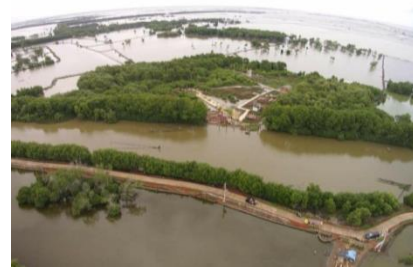
Gambar 1.2 Foto lokasi proyek jembatan MB-04
