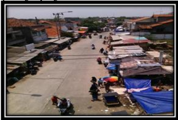
Gambar 1. Kondisi Eksisting Akses Jalan Pasar Gebang
